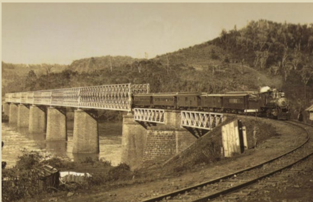
Maria-fumaça – trem a vapor – atravessando a ponte sobre o rio Uruguai, na divisa entre os Estados de Santa Catarina e Rio Grande do Sul, 1930.
